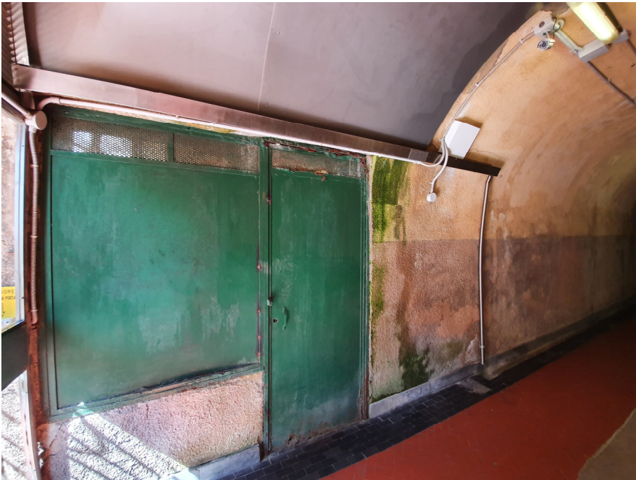
Foto 3 – Piedritto sinistro del tunnel in corrispondenza dell'imboccatura: si osserva la presenza di un locale (foto del 19/06/2020).
