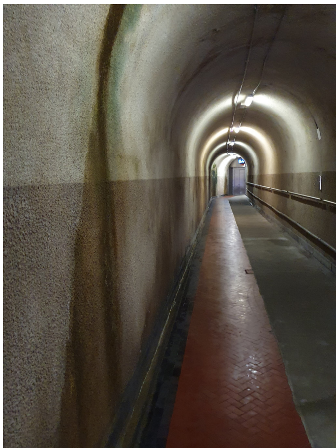
Foto 6 – Vista del tunnel circa dalla progressiva +20m verso l'interno (foto del 19/06/2020).
