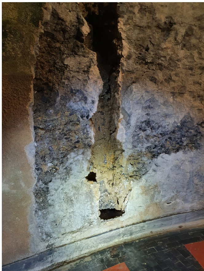
Foto 12 – Dettaglio dello scolo verticale: in basso si nota il pozzetto di raccolta raccordato alla tubazione di allontanamento delle acque (foto del 13/07/2020).
