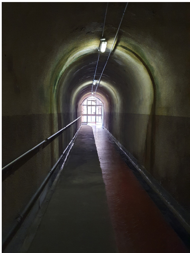
Foto 5 – Vista del tunnel circa dalla progressiva +20m verso l'imboccatura (foto del 19/06/2020).
