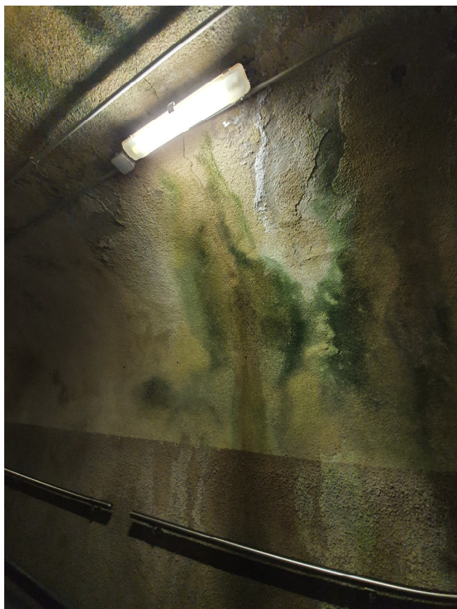
Foto 8 – Vista del piedritto destro del tunnel circa alla progressiva +20m (foto del 19/06/2020).
