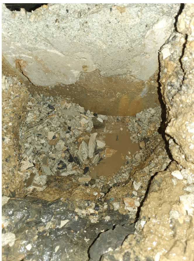
Foto 13 – Vista del pozzetto scavato in roccia. (foto del 13/07/2020).
