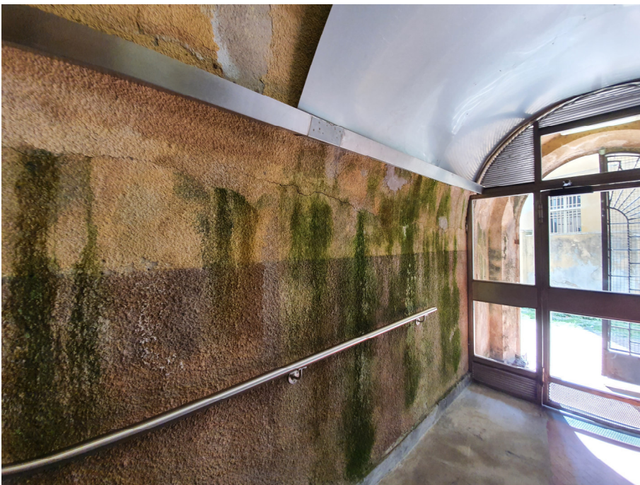
Foto 4 – Piedritto destro del tunnel in corrispondenza dell'imboccatura (foto del 19/06/2020).
