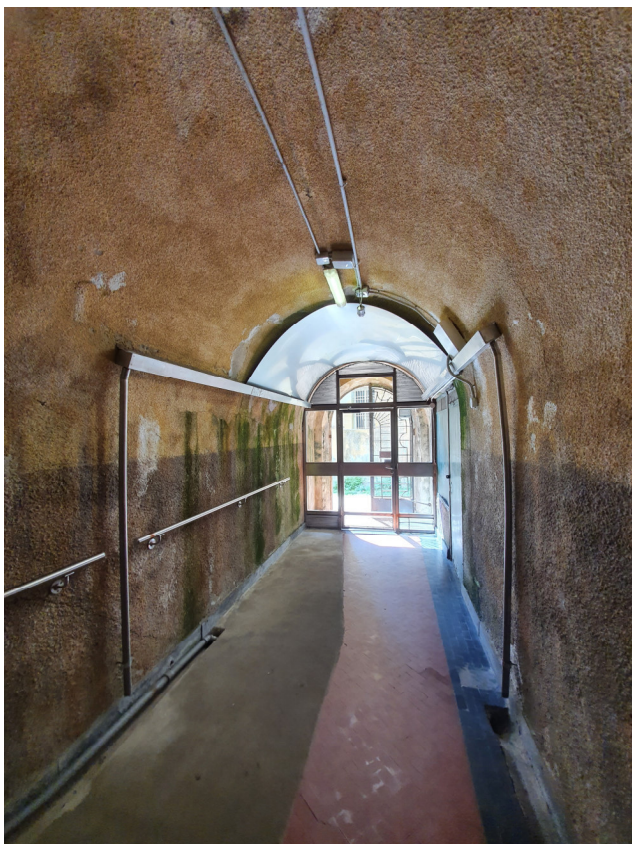
Foto 2 – Primo tratto di tunnel: foto scattata in corrispondenza della progressiva +5m verso l'imboccatura (foto del 19/06/2020).
