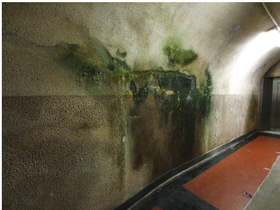
Foto 9 – Vista del piedritto sinistro del tunnel circa alla progressiva +40m (in fondo si vede l'ascensore) (foto del 19/06/2020).
