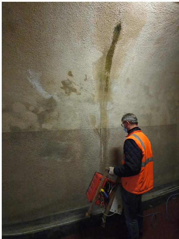
Foto 15 – Foto scattata durante l'esecuzione dell'indagine Ground Penetrating Radar (GPR) in data 13/10/2020.
