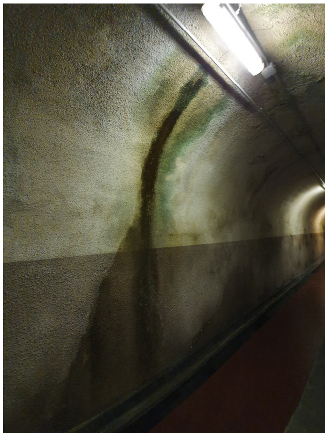
Foto 7 – Vista della parete sinistra del tunnel circa dalla progressiva +20m (foto del 19/06/2020).
